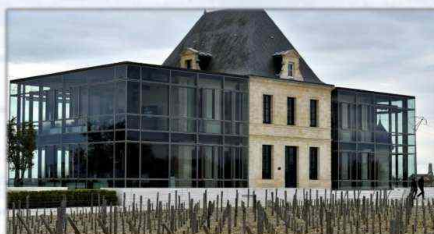
Le Château Pédesclaux – Pauillac transformé en 2017 par les architectes Jean-Michel Wilmotte et Arnaud Boulain,
