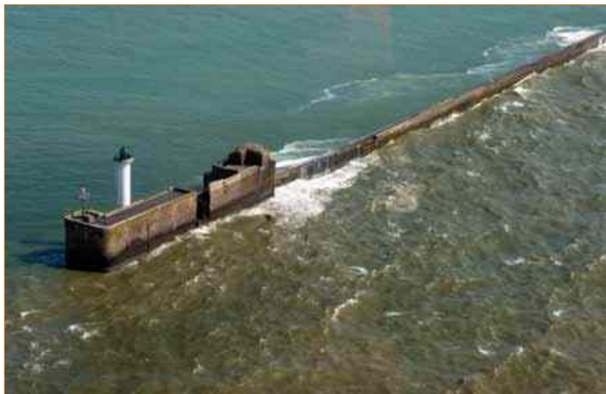
Digue à Boulogne-sur-Mer, dans le Pas-de-Calais (62).
