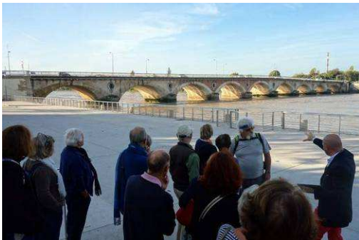
Le pont de pierre de Libourne de 1822 est également un magnifique témoignage du riche passé de la ville.
